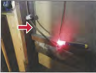
Knob & tube wiring
